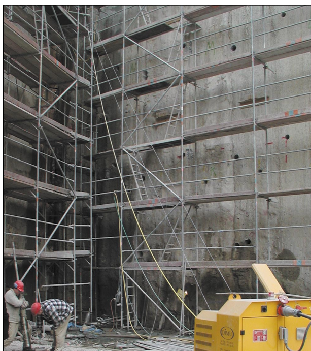
3 Seilsäge beim Trennen der Schlitzwände
